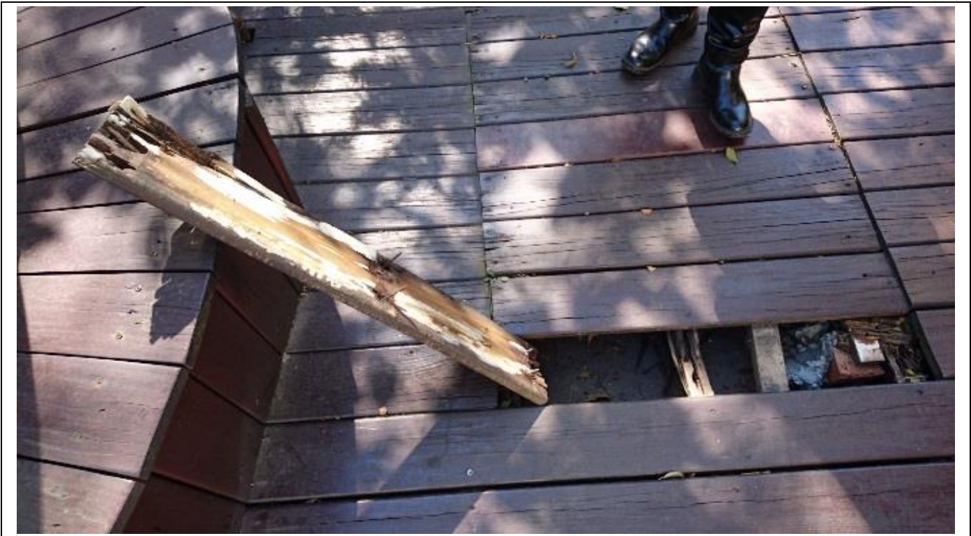
說明：改善前-木質地板腐朽、塌陷
