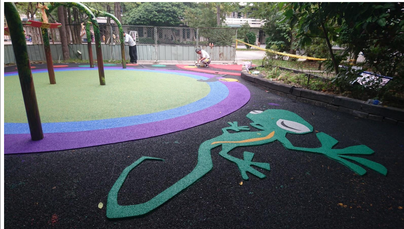
說明：施工中-裝設新鞦韆、鋪設新地墊
