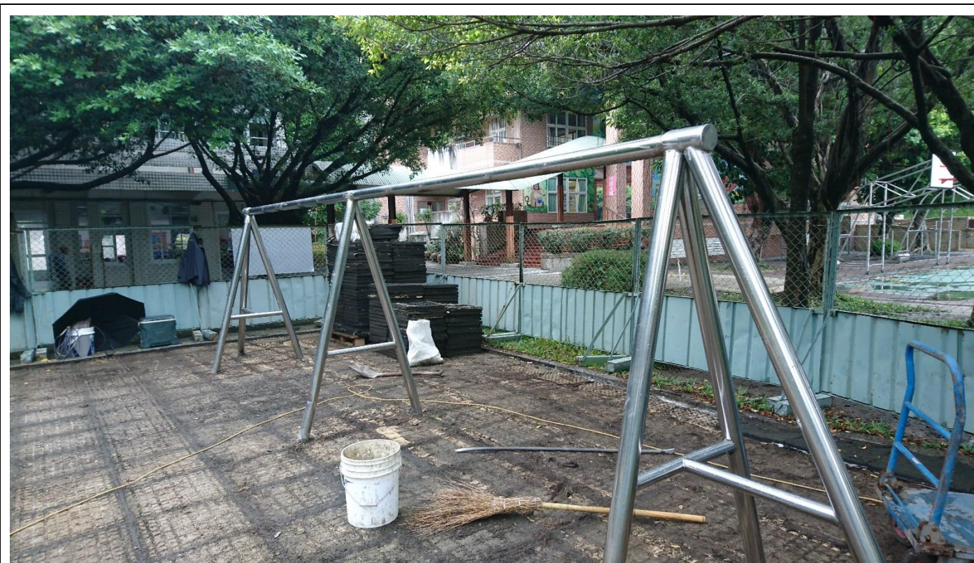
說明：施工前-地墊拆除
