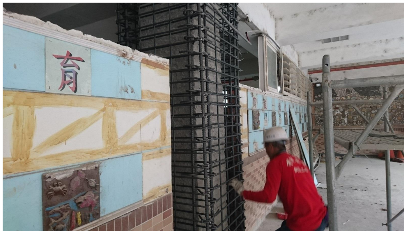
說明：鋼筋綁紮
