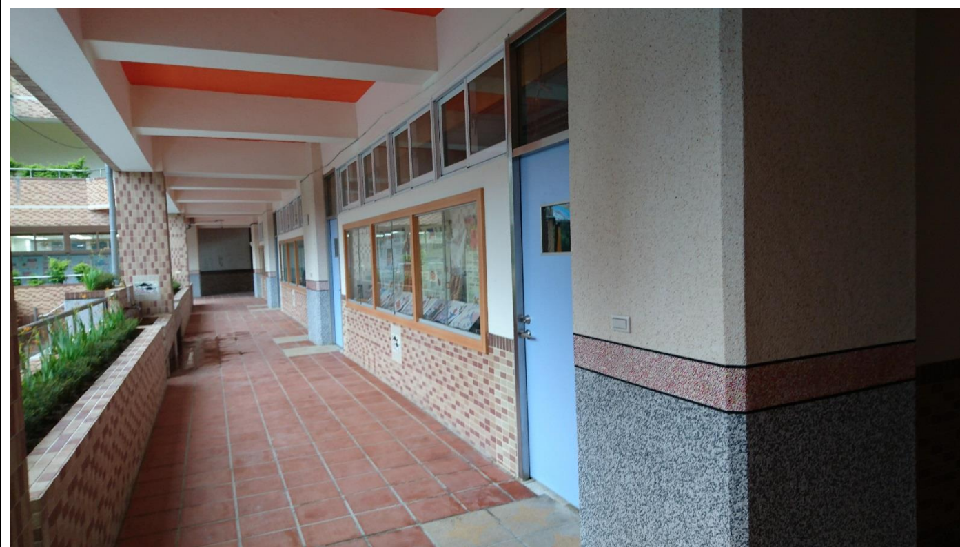
說明：工程完工照
