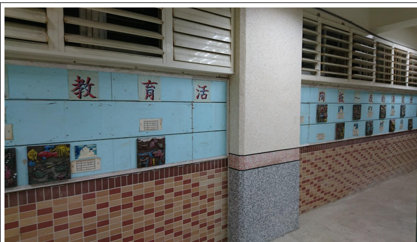
說明：擴柱完成
