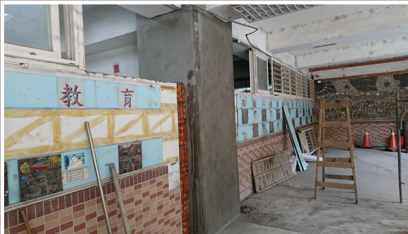
說明：混凝土澆置完成
