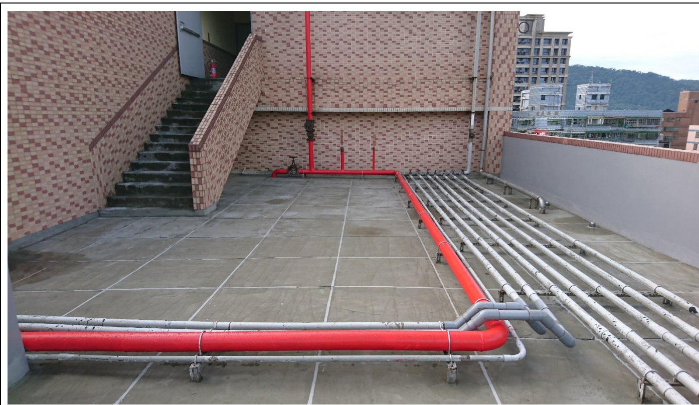
說明：頂樓防水隔熱完工
