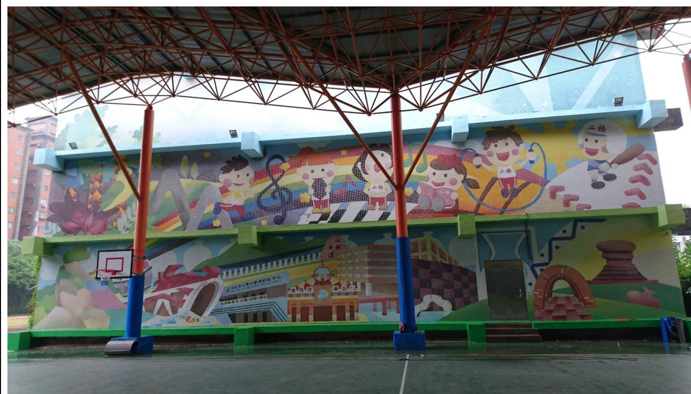
說明：側牆馬賽克拼貼完工
