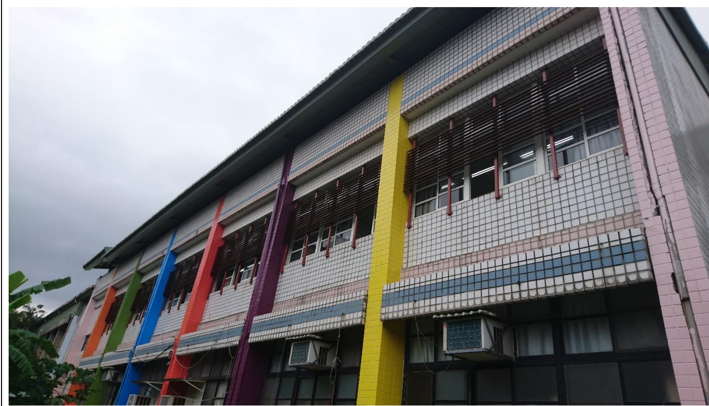
說明：改善後-和平樓窗戶建置遮陽格柵
