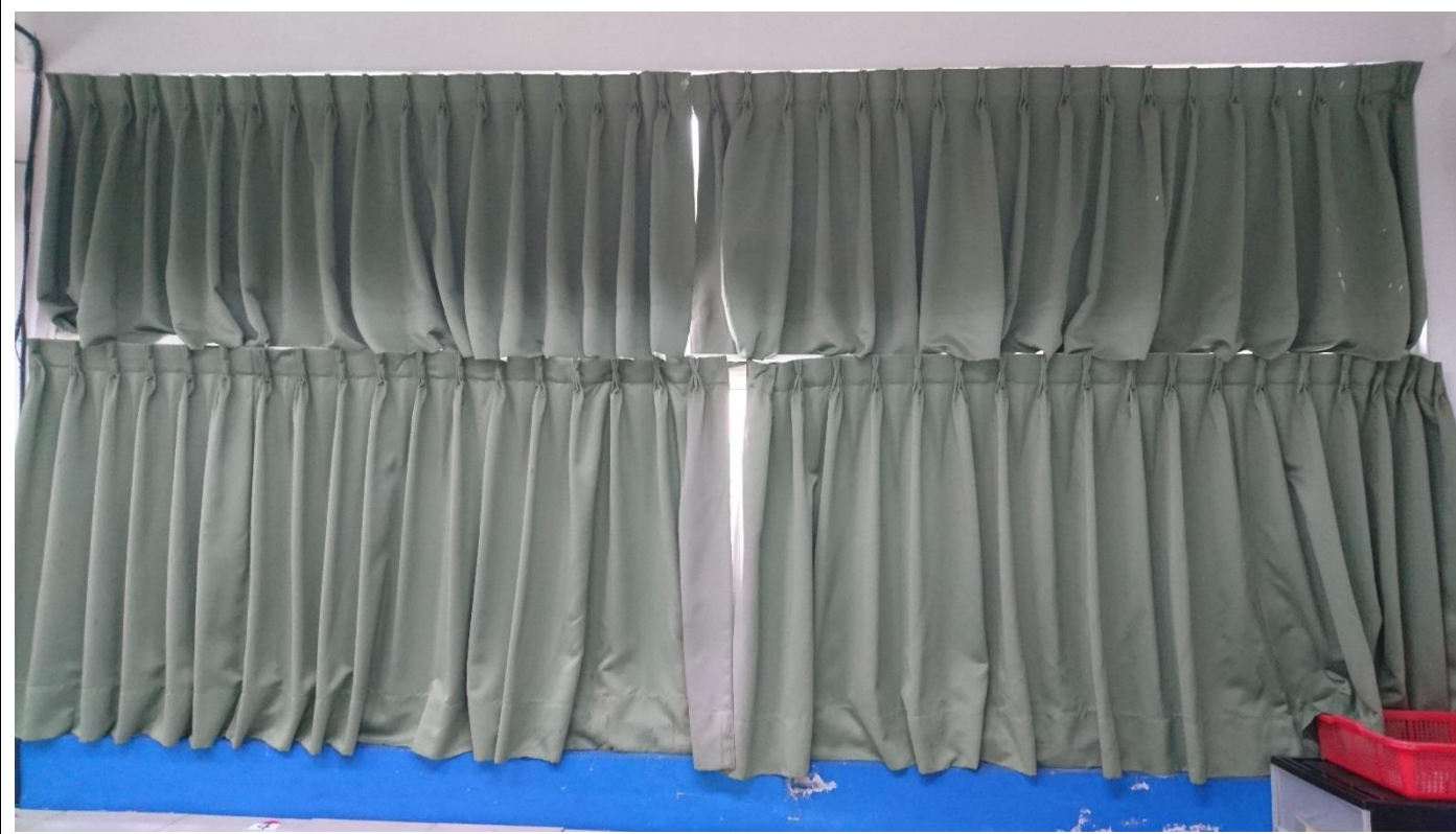
說明：改善後-窗簾軌道修復
