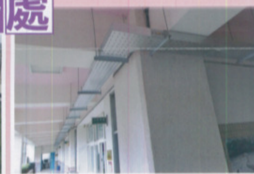
電力改善工程
