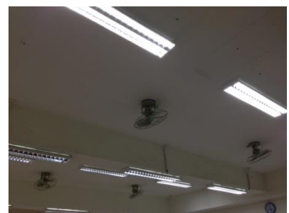
104.10.02 行政樓地下室汰換節電燈具後
